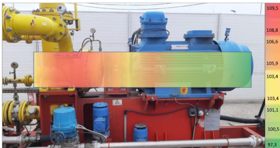
Fig. 2.5 Analiză zgomot. Distribuția câmpului acustic - Activități de mentenanță ale autorului în locația compresorului studiat- Valori măsurate în dB [decibeli]. Măsurările au evidențiat faptul că zona cu radiația acustică cea mai mare a fost carcasa compresorului.
